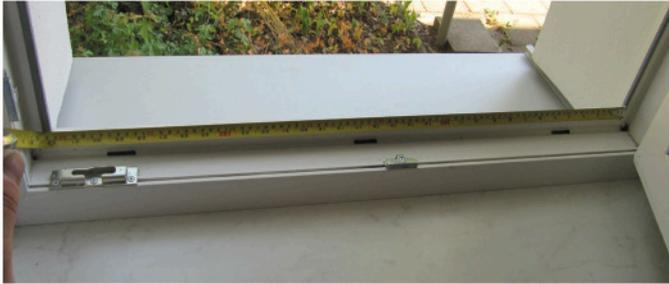
Messen Sie bei geöffnetem Fenster die lichte Breite zwischen dem Fensterrahmen. Ziehen Sie vom ermittelten Maß bitte 2 mm ab.
