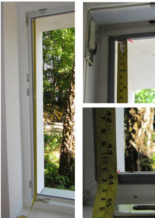
Messen Sie bei geöffnetem Fenster die lichte Höhe zwischen dem Fensterrahmen. Ziehen Sie vom ermittelten Maß bitte 2 mm ab.
